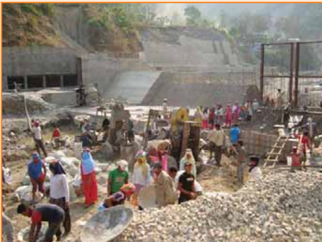
हेडवर्क्स निर्माण कार्य भईरहेको
